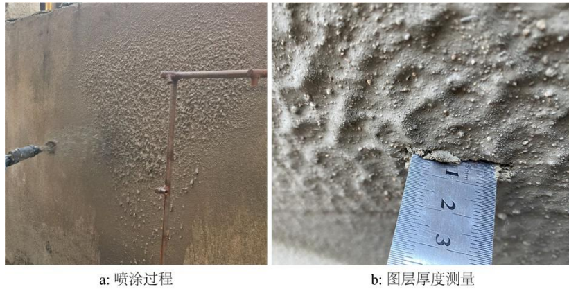
图 2 喷涂过程和涂层厚度测量
